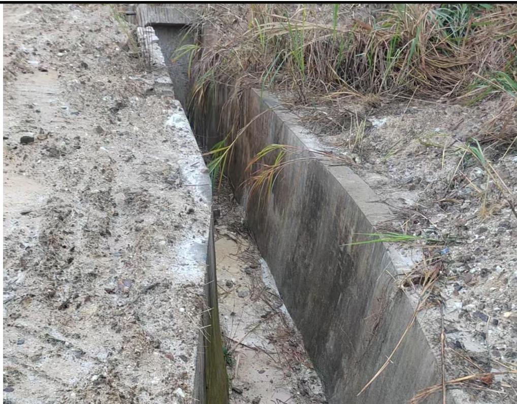
库区排水沟渠
